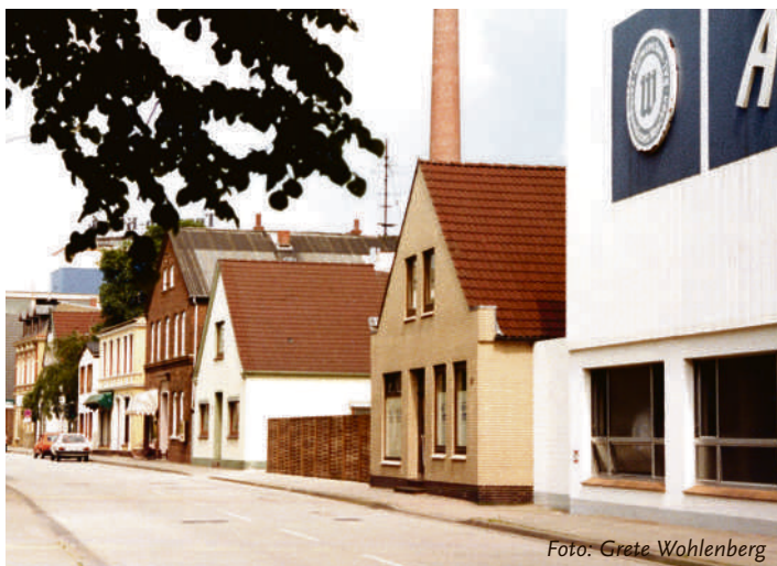
Die beiden Wohnhäuser in der Mitte wurden für die Erweiterung der Wäscherei abgerissen.
